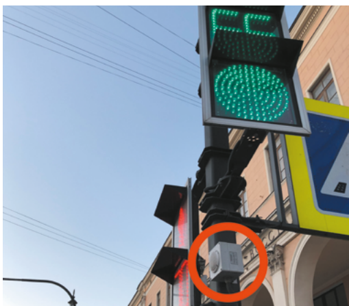
Рисунок 4. Устройство речевого и звукового дублирования сигналов светофора
